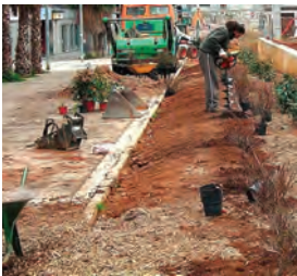
▲ Ejemplo de proceso de plantación: preparación del terreno en profundidad, enmendado, plantación y resultado un año después.
