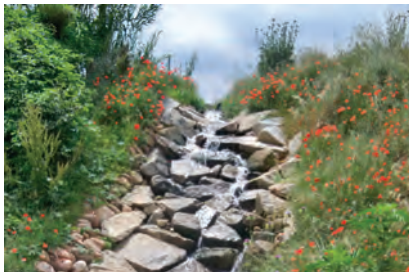
Tramo de rápidos con escollera
