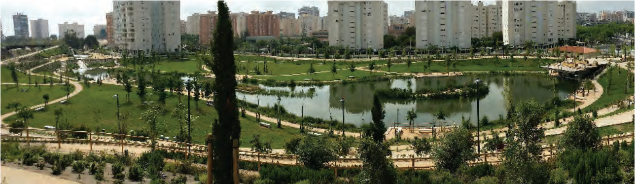
▲ Parque inundable de La Marjal. Solución basada en la naturaleza para la retención de aguas de tormenta. Aguas de Alicante.
