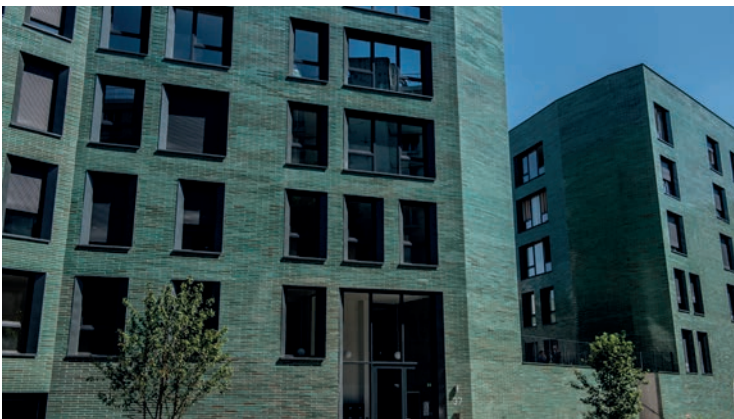
Les docks de Ris, Ris-orangis, Île-de-France, Étape 3, 2016 # Eau chaude sanitaire # Géothermie # Réseau de chaleur
