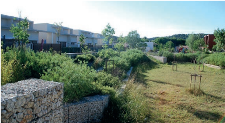
Projet Horizons Viala-Est, Prades-le-Lez, Occitanie, Étape 3, 2014 # Phénomène cévenol # Bassin de rétention
