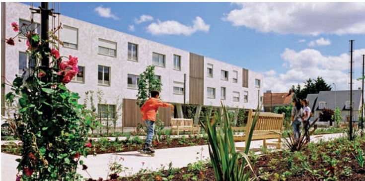
ÉcoQuartier Monconseil, Tours, Centre-Val de Loire, Étape 3, 2014
