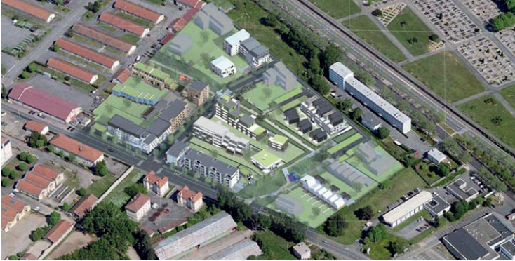
ZAC Biancamaria, Vandoeuvre-lès-Nancy - Tranches 1 et 2, Grand Est, Étape 3, 2018 # Centrale biomasse # Réseau de chaleur urbain
