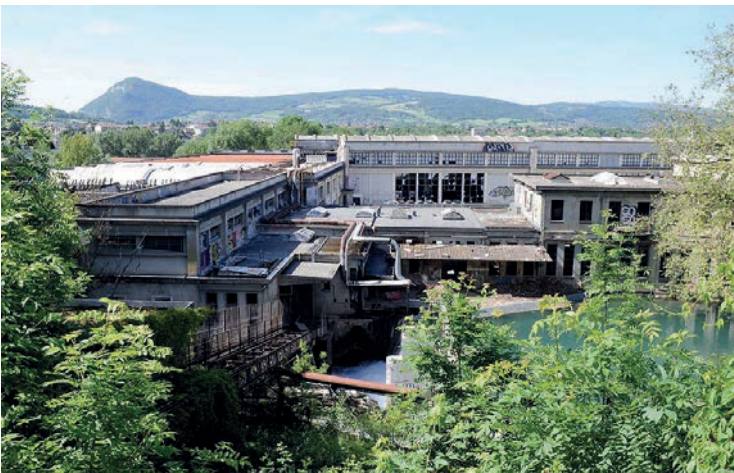
Les passerelles, Cran-Gevrier, Auvergne-Rhône-Alpes, Étape 3, 2017 # Végétalisation # Solutions fondées sur la Nature (SFN)
