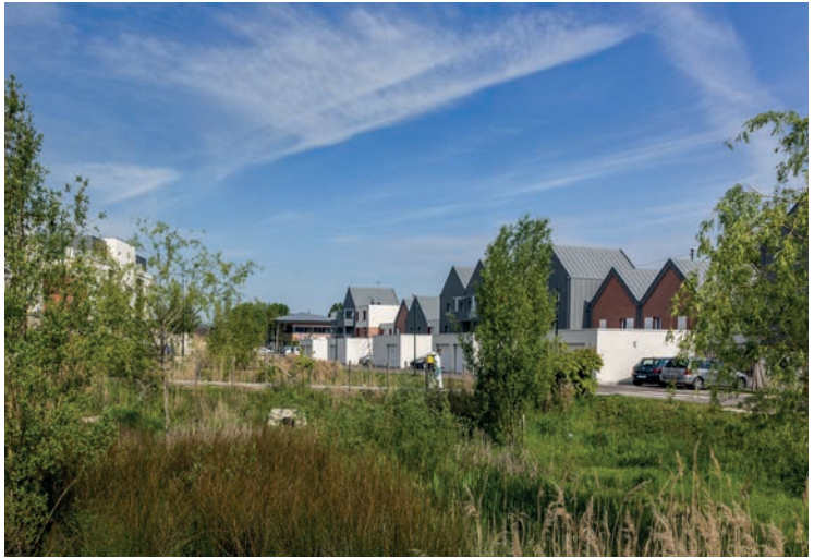
ÉcoQuartier des Arondes, Roncherolles-sur-le-Vivier, Normandie, Étape 3, 2017
