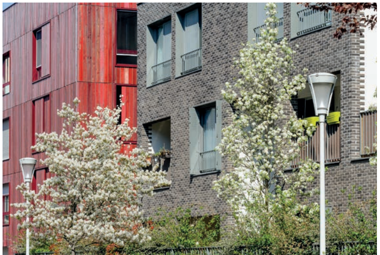
Hoche, Nanterre, Île-de-France, Étape 3, 2014 # Suivi des consommations énergétiques
