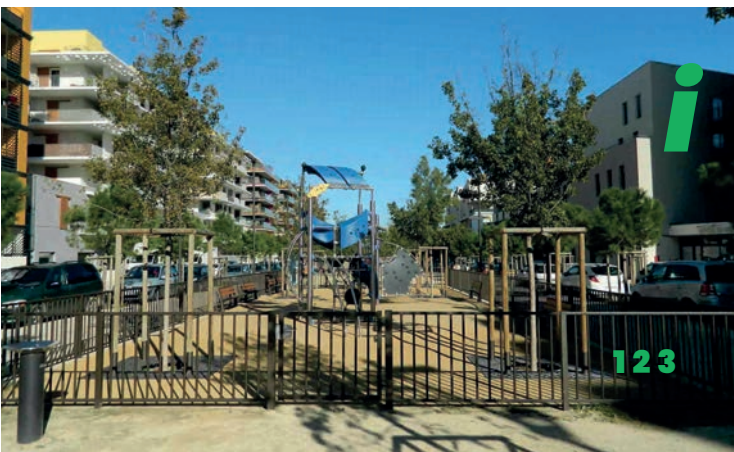
Les Grisettes, Montpellier, Occitanie, Étape 3, 2015 # Réseau de chaleur
