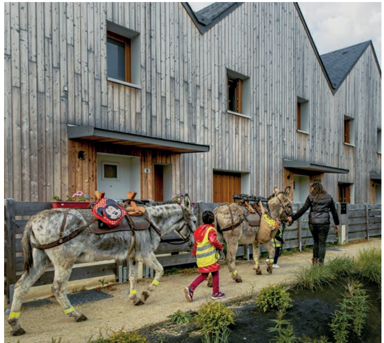
Éco Village des Noés, Val-de-Reuil, Normandie, Étape 3, 2016 # Liaison douce # Transport scolaire # Stationnement vélo
