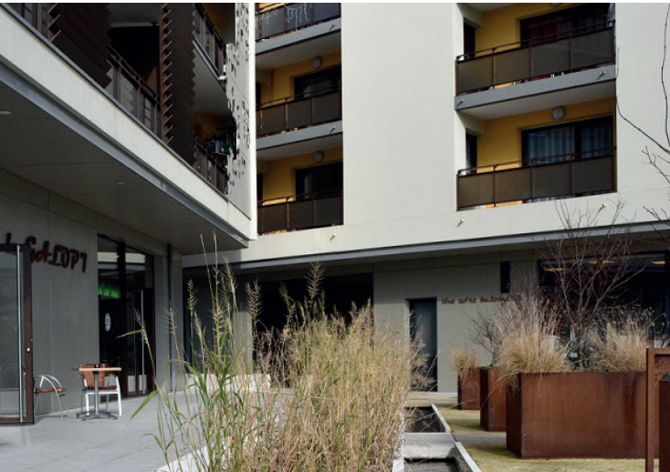
La Barberie, Changé, Pays-de-la-Loire, Étape 3, 2014 # Réseau de chaleur urbain # Panneau Photovoltaïque
