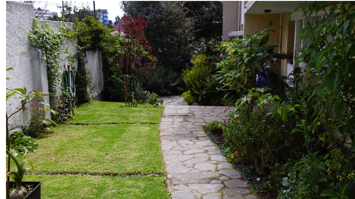
Zanjas de infiltración, evita el envío al alcantarillado del agua lluvia en fuertes lluvias, jardín Casa Armero, Quito
