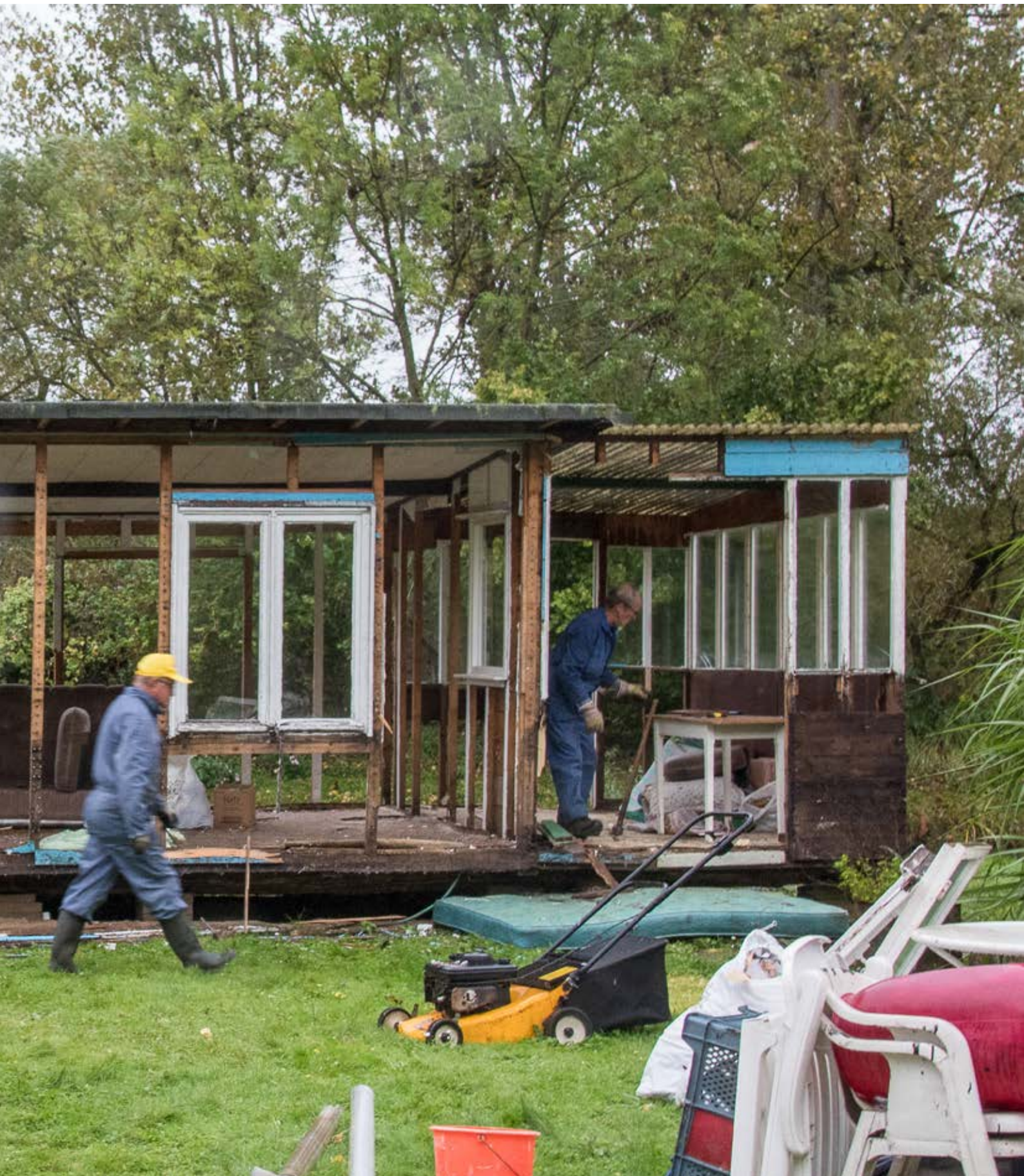
De sloop van vakantiewoningen maakt meer ruimte voor de Kleine Nete. Project: De Kleine Nete. Foto: Wout Opdekamp
